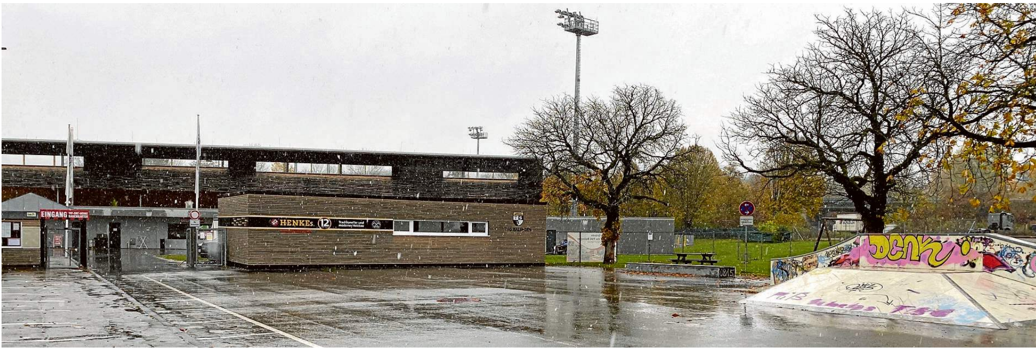
Die ohnehin schon knapp bemessene Parkfläche vor der Bizerba-Arena wird durch den Bau der McArena nochmals verkleinert.
